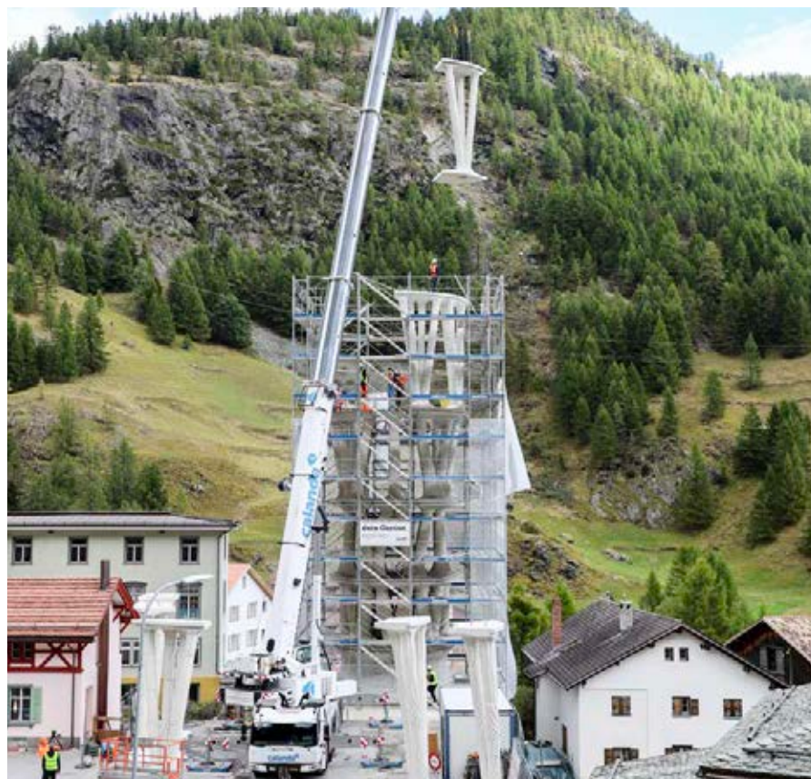
Turmbau in Mulegns: Die vierte Ebene des Tor Alva wird mithilfe eines Kranfahrzeugs montiert.
