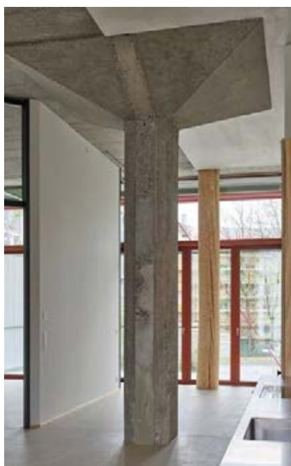
Statik wird zur Skulptur im Raum. Pilzförmige Stütze im Dialog mit neuer Rundstütze aus Holz.
