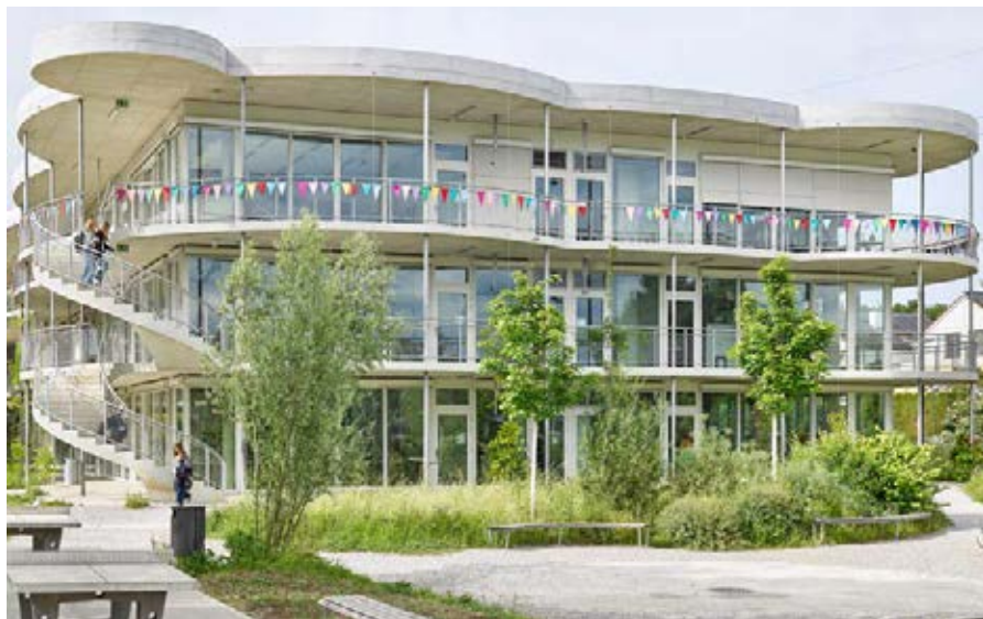
Die bepflanzten Entwässerungsmulden verwandeln sich bei Gewittern temporär in Seen.
